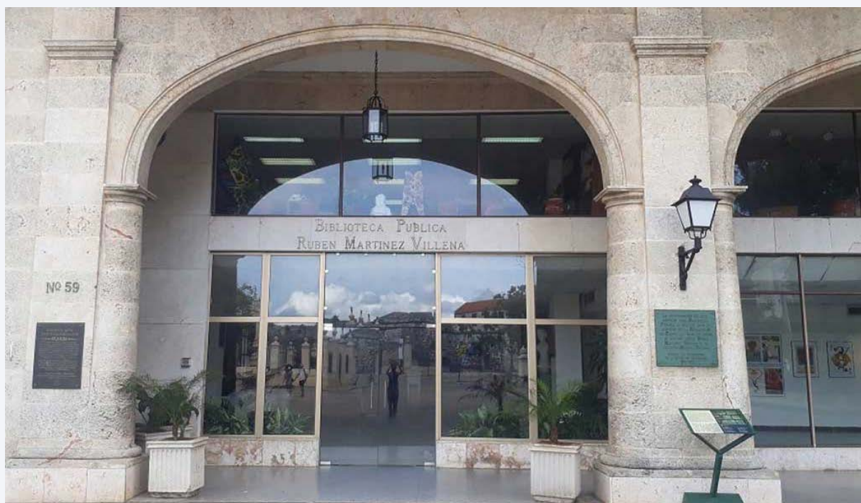
Entrada de la Biblioteca Villena. (Foto tomada de www.bpvillena.ohc.cu ).
